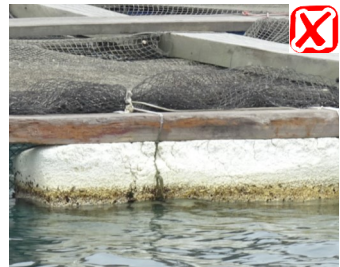
任由發泡膠浮泡損壞而不及時維修
