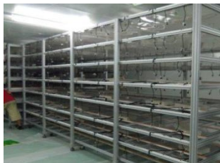
(6) 安裝栽培架的支架與電路
