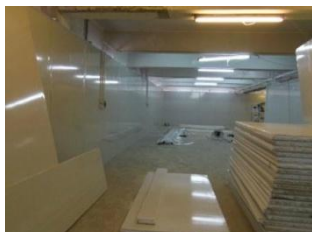
(2) 安裝隔熱圍板
