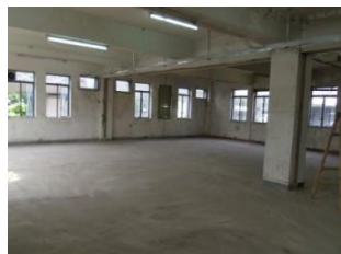
(1) 平整中心地面
