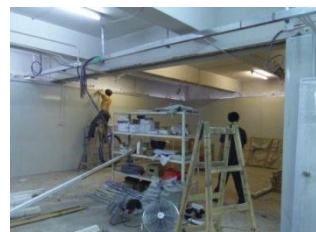
(4) 安裝室內空調及照明設備；敷設主要喉管及電線
