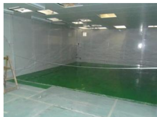
(5) 鋪設中心地面覆膜
