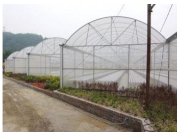
環控溫室外貌
