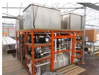
特製的營養液貯存、降溫及輸出過濾裝置
