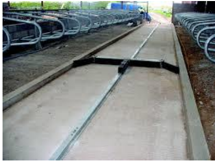
27. 自動刮糞系統 用於清除禽畜廢物。
