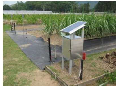
20. 電圍網 防止野生動物破壞農作物。
