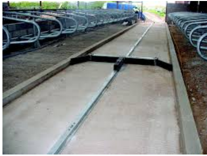
27. 自動刮糞系統 用於清除禽畜廢物。
