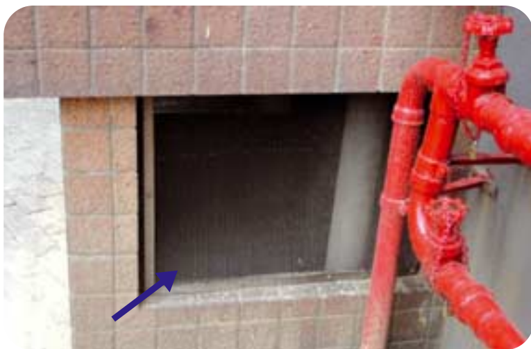
在通氣口安裝網孔不大於六毫米的鐵絲網
