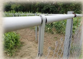
新設計加入滾筒防止野豬從上跳進
