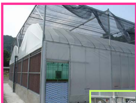
環控溫室外貌
