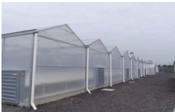
環控溫室外貌
