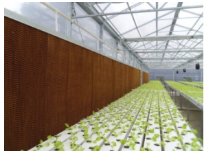
水牆及抽氣扇控制溫室內的濕度和溫度
