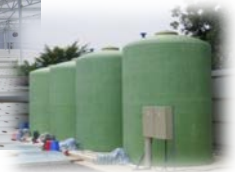
配上過濾和消毒設備的營養液循環及貯存系統
