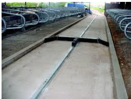
27. 自動刮糞系統 用於清除禽畜廢物。
