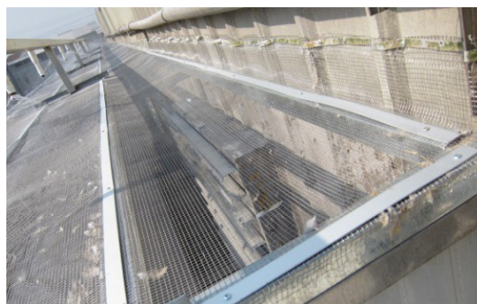
26. 灑水系統 置於雞舍抽風機外，以減少雞毛飛散。
