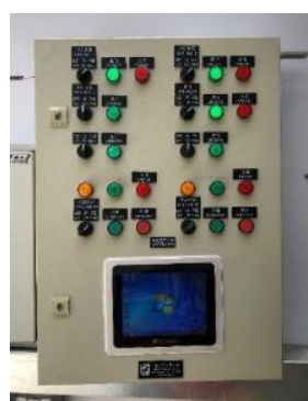
48. 農場遙距監控系統 用於遠端監察農場環境及控制各種儀器。
