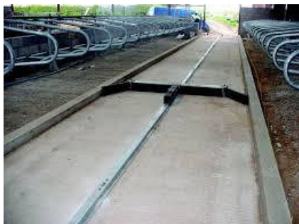
27. 自動刮糞系統 用於清除禽畜廢物。
