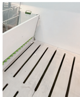
水泥混凝土漏縫地板
