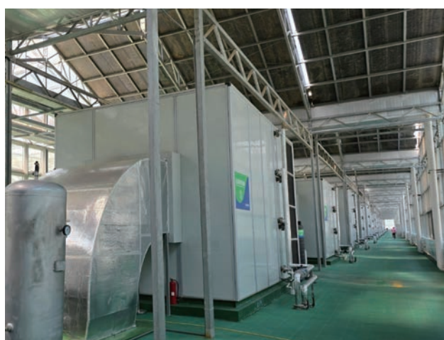
每小時120000立方米水簾降溫正壓風機
