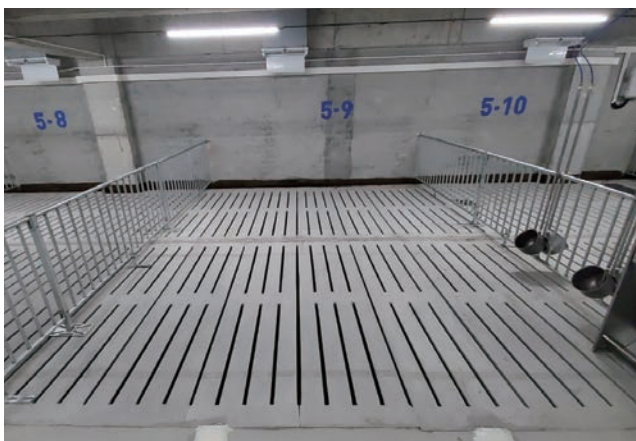
水泥混凝土漏縫地板：育肥欄
