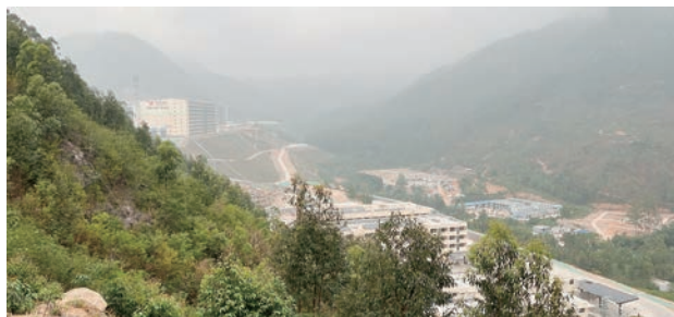
由觀景台拍攝的養殖場建築遠景
