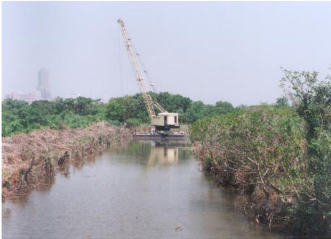
照片三 正在保護區內清理基圍河道的大型挖土機（攝於2003年）
